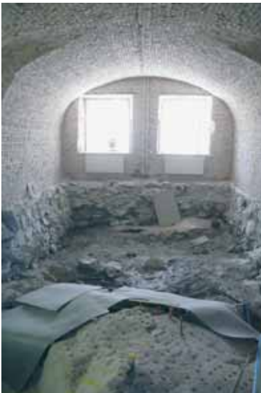
Tältä ruokasali näytti purkutöiden aikana ja uudistettuna. Kosteuden poistaminen vaati rakenteiden purkamista kalliopintaan asti.
