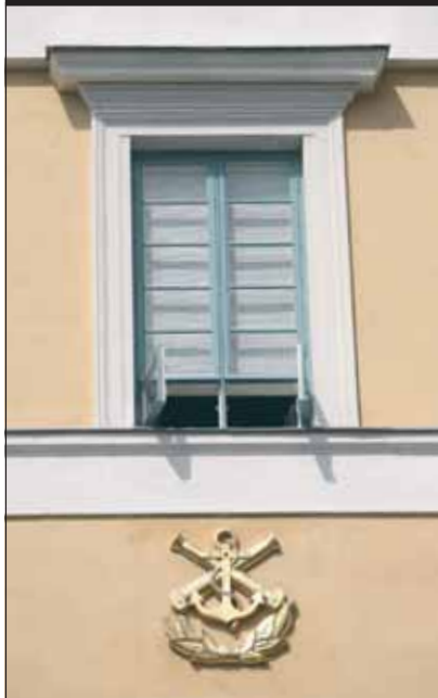
Suomenlinnassa Merisotakoulun laaja korjaushanke on valmistunut.
