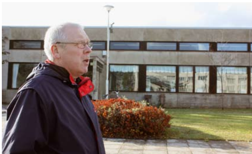
– Rakennuksia on korjattu vuosi vuodelta ja seuraavaksi peruskorjattavaksi tulee taustalla oleva ruokala-sotilaskoti-keskusvarastorakennus, kertoo Rakennuslaitoksen paikallispäällikkö Kauko Patteri.
