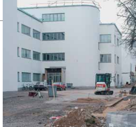
Rakennetaanko uutta vai korjataanko vanhaa riippuu sitä kumpi tulee edullisemmaksi. Kuvassa Niinisalon funkiskasarmi, joka on korjattu nykyajan tarpeita vastaavaksi.
